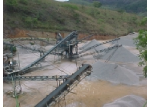
Foto 6 – Sistema de britagem - Pedreira Morro Azul .
