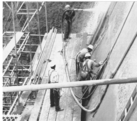
Figura 2.10: Aplicação de concreto projetado na face do muro (Manual Solotrat, 2006).
