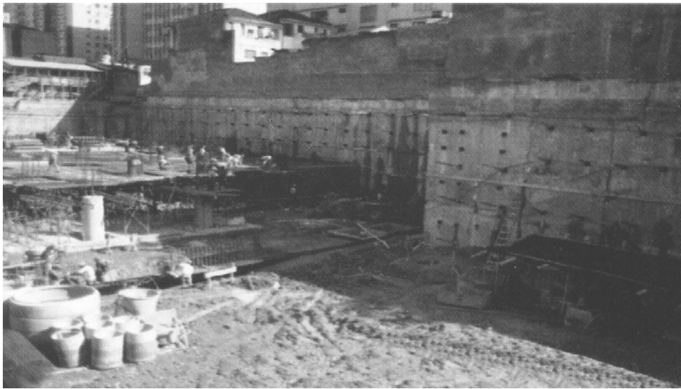
Figura 2.7: Muro de solo grampeado (Manual Técnico Solotrat, 2006).
