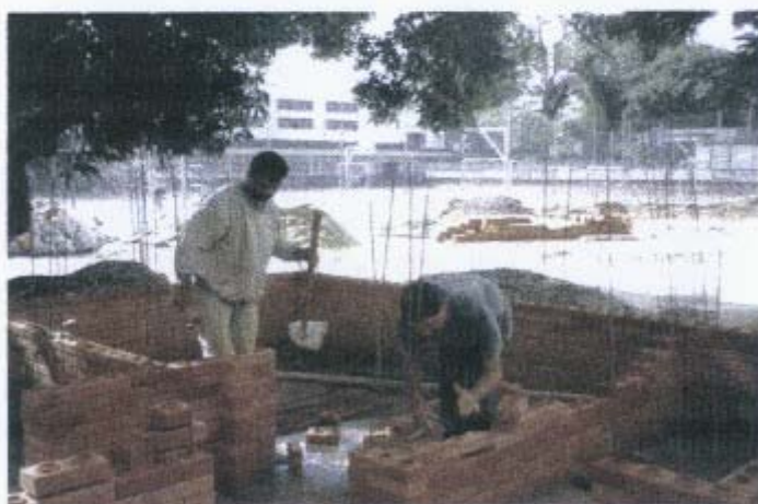
figura 6.4 – alvenaria por encaixe
