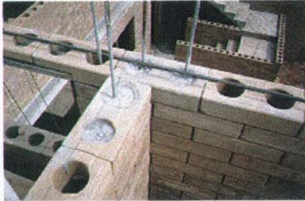
figura 6.5 – enchimento dos encontros de parede com argamassa
