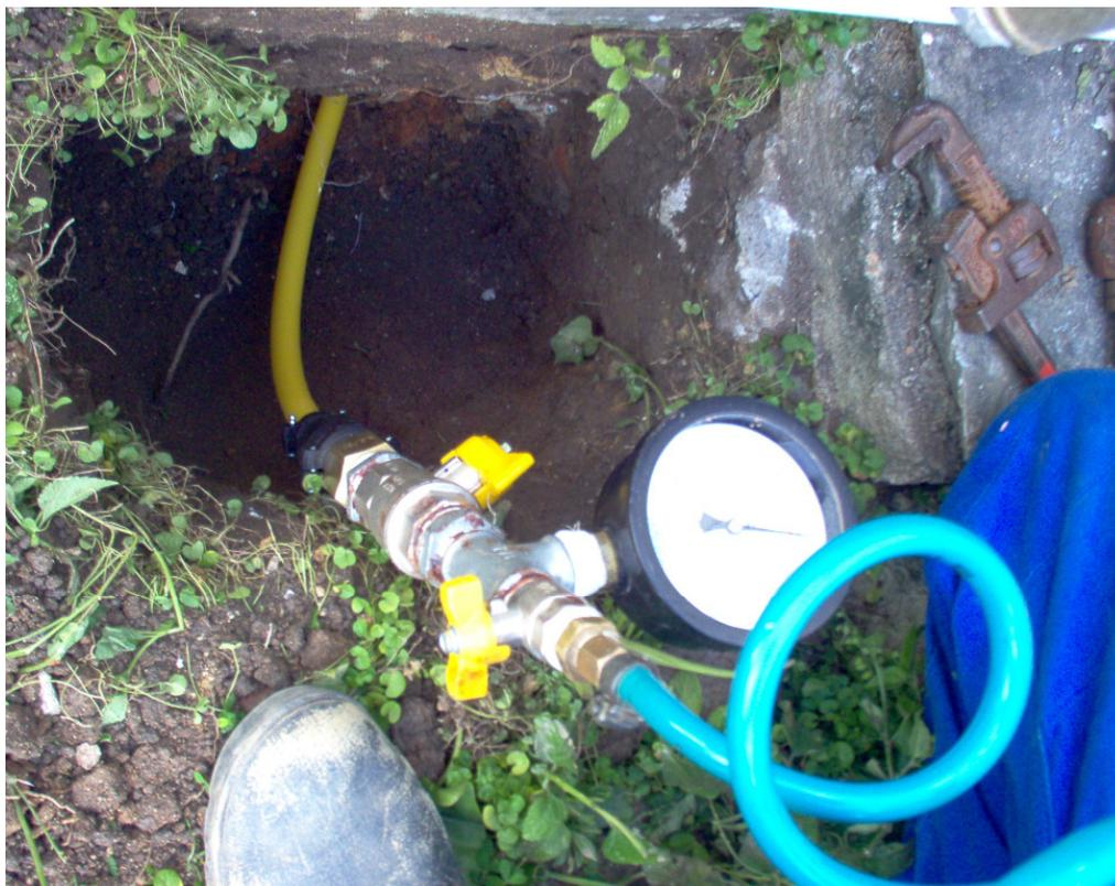
Figura 6. Ensaio de Estanqueidade.
