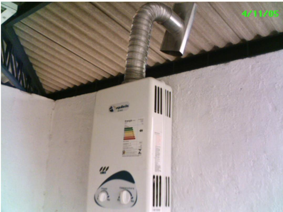
Figura 12. Foto de um aquecedor de passagem com chaminé individual.
