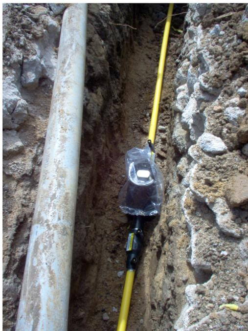
Figura 14. Válvula de segurança instalada antes do regulador de pressão.
