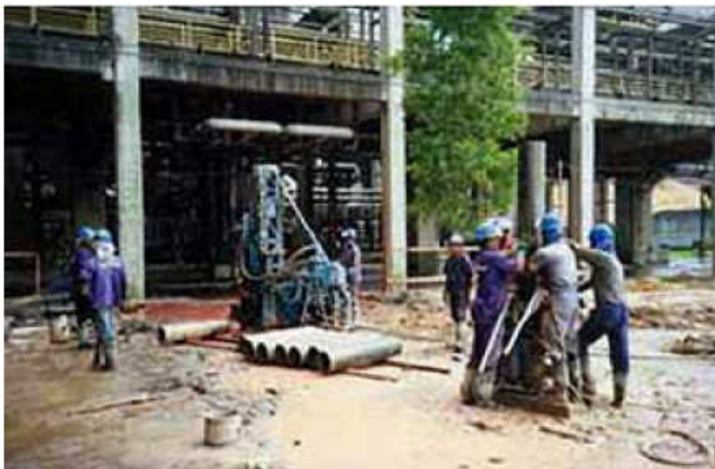
Figura 21 – Exemplo de um canteiro de obra com execução das estacas raiz, destacando-se o tamanho reduzido da perfuratriz e os revestimentos recuperáveis utilizados nos furos (Brasfond, 2002).
