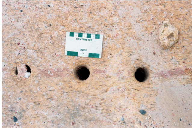
Figura 7 – Furos na rocha para colocação do equipamento cortante
