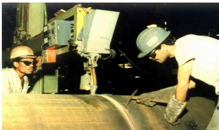
**Figura 2.5 – Retirada da EFS durante a soldagem.**
