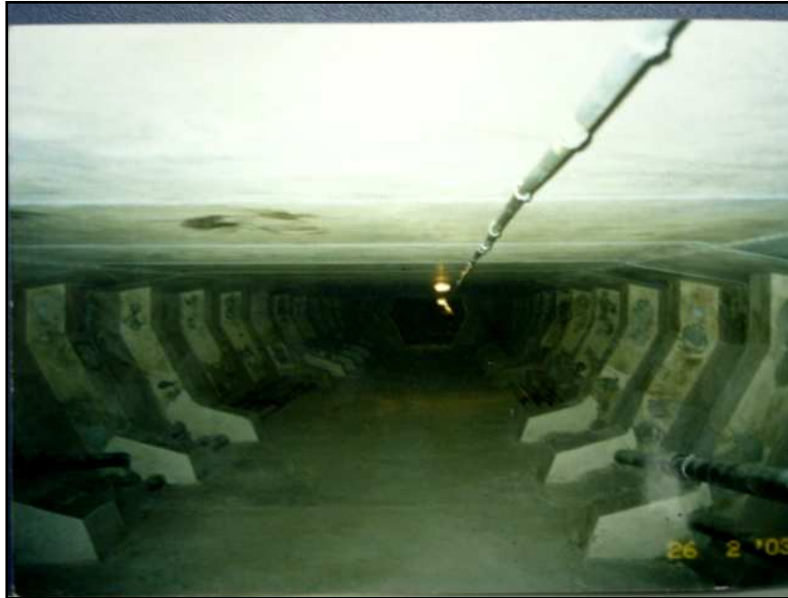
Figura 3.18 - Ilustração do interior de um dos vãos do viaduto (GARCIA et al , 2007).
