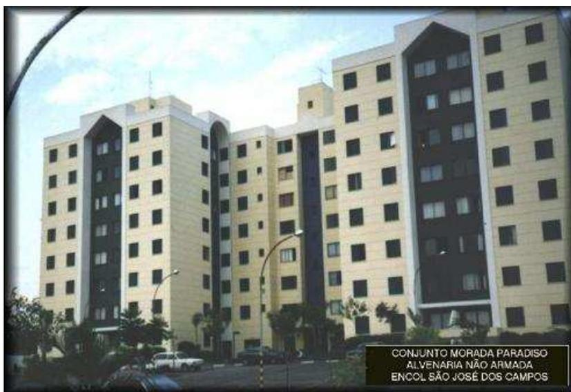
Figura 2.9 - Conjunto Morada do Paraíso, construído pela Encol em alvenaria não armada – Fonte: Silva (2005).
