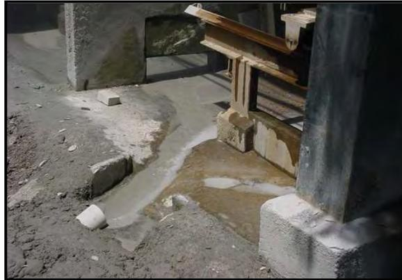
Fig. 2.14 - Direcionamento da água com RCR para o tanque de decantação
