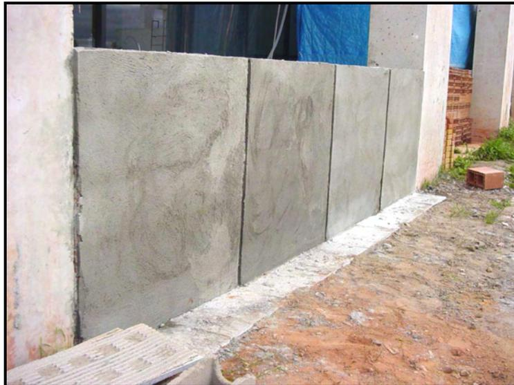
Fig. 3.34 - Painéis de revestimento em argamassa (4 de cada lado da parede).
