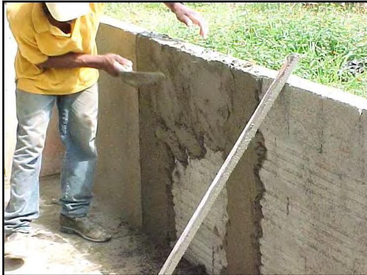
Fig. 3.33 - Pedreiro aplicando revestimento em massa única.
