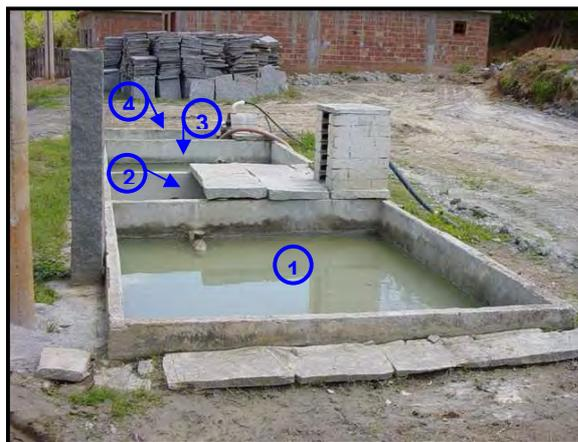
Fig. 2.15 - Tanque de decantação do resíduo sólido
