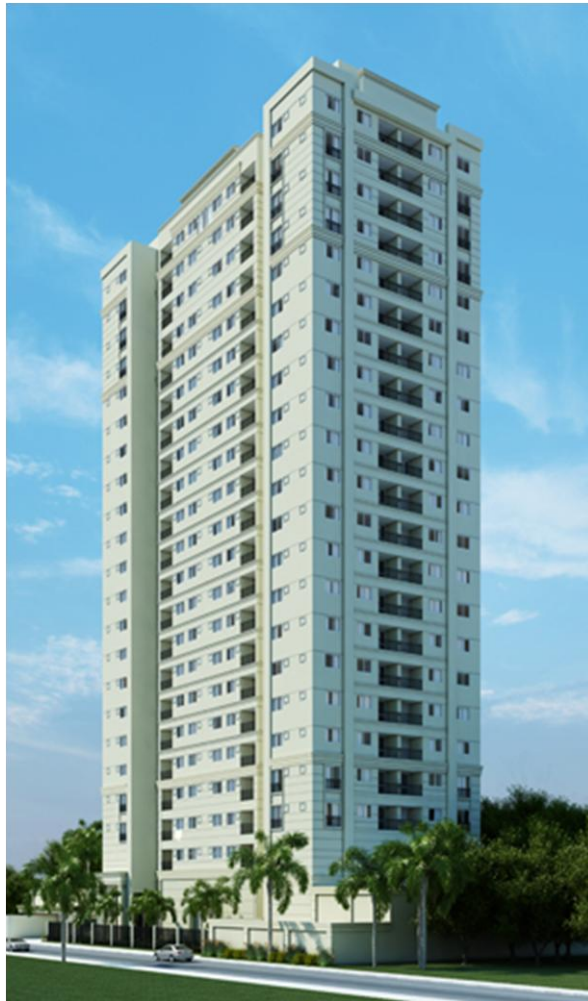
Figura 1.1. Fachada do edifício
