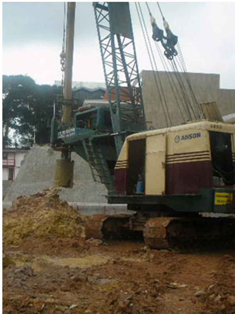
Figura 2.1. Execução de uma escavação
