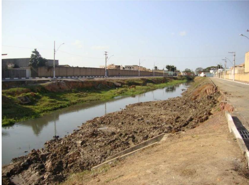
*Figura 2.4 - Escorregamento da margem esquerda do Canal próximo à Avenida Alberto Lamego*
