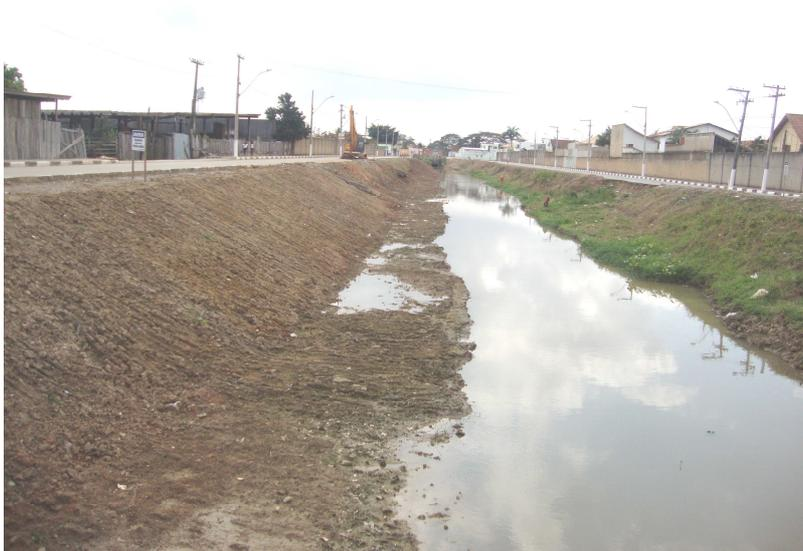
*Figura 2.11 – Margem esquerda sem material erodido*
