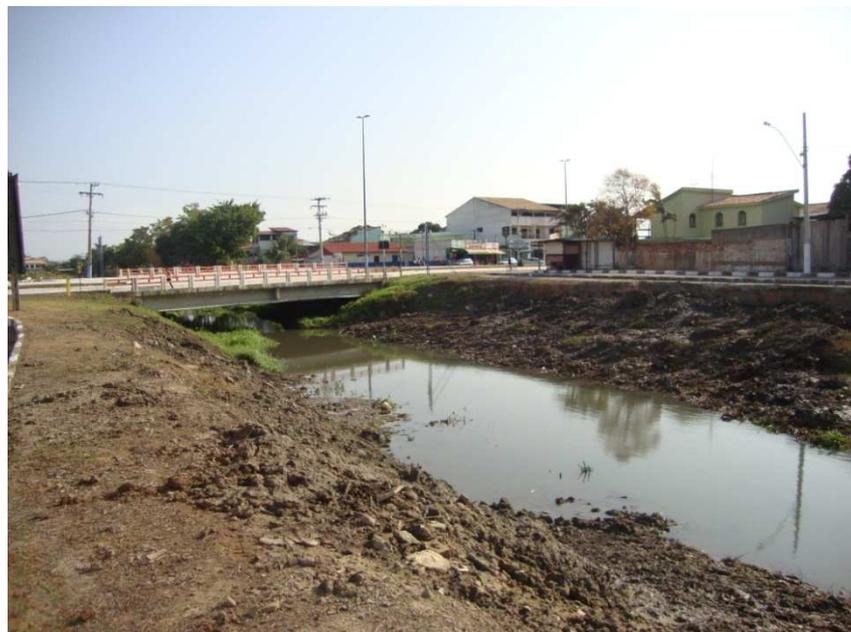
*Figura 2.5 - Escorregamento das duas margens próximo à ponte da Avenida Alberto Lamego*
