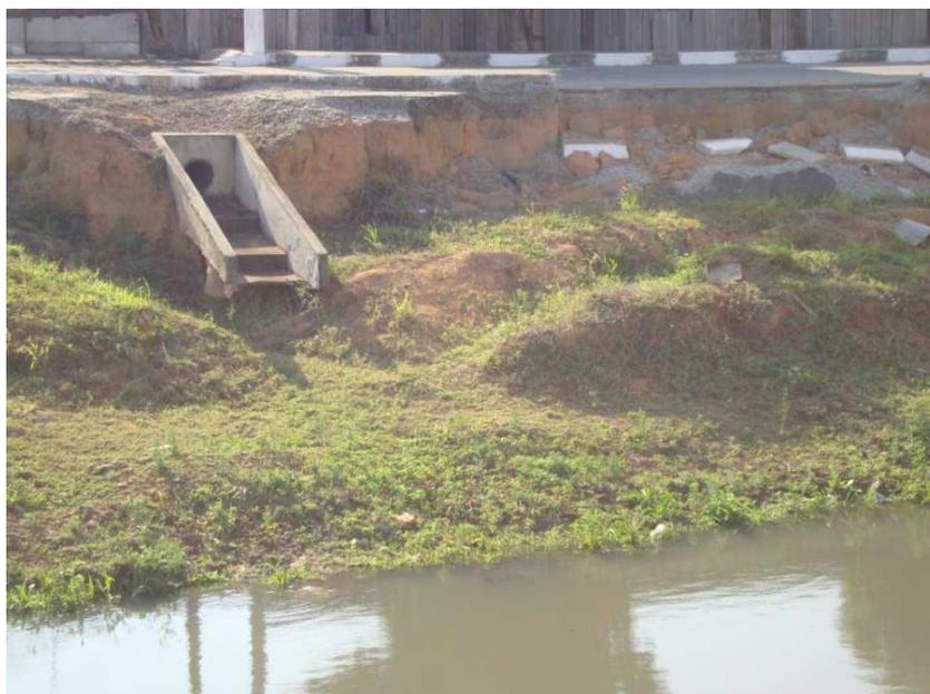
*Figura 2.9 – Descidas d'água na margem esquerda entre o Rio Paraíba do Sul e a Avenida Alberto Lamego*
