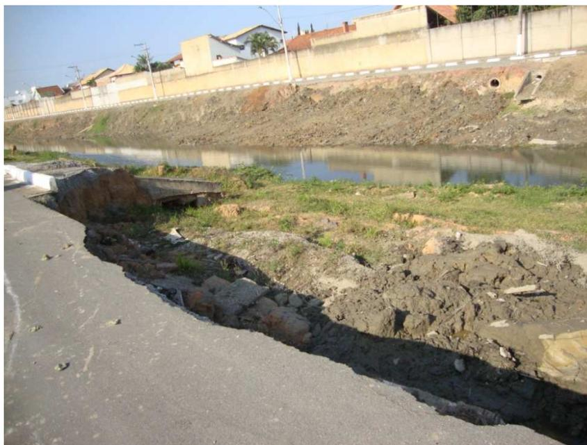
*Figura 2.6 - Escorregamento e queda de parte da pavimentação de uma das margens*
