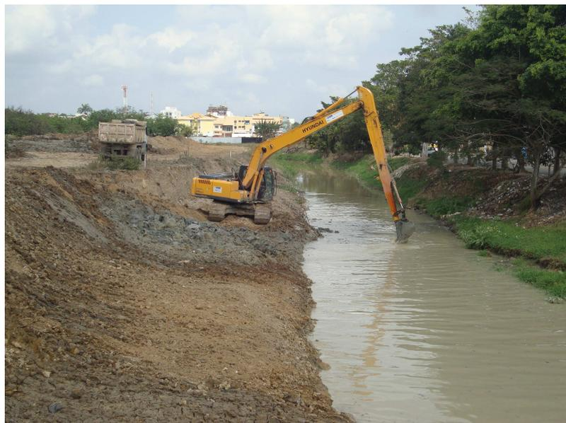
*Figura 2.13 – Equipamento realizando a dragagem do canal*
