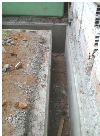
Figura 4 – Mureta guia concretada (FONTE: Geodactha, 2003).
