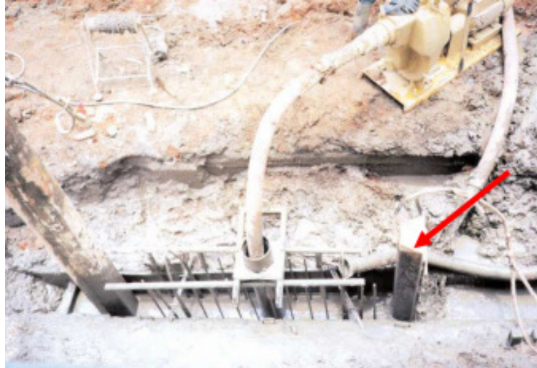
Figura 7- Chapas-junta (FONTE: Varela, no date ).
