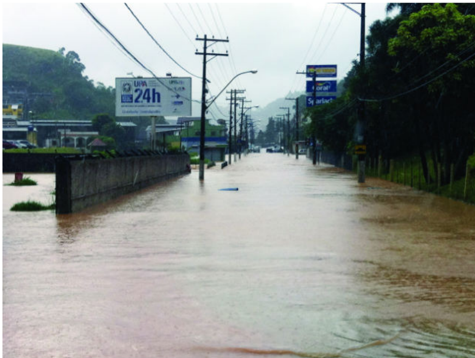
Figura 1 – Inundação no Bairro Meudon (FONTE: Netdiário, 2013).
