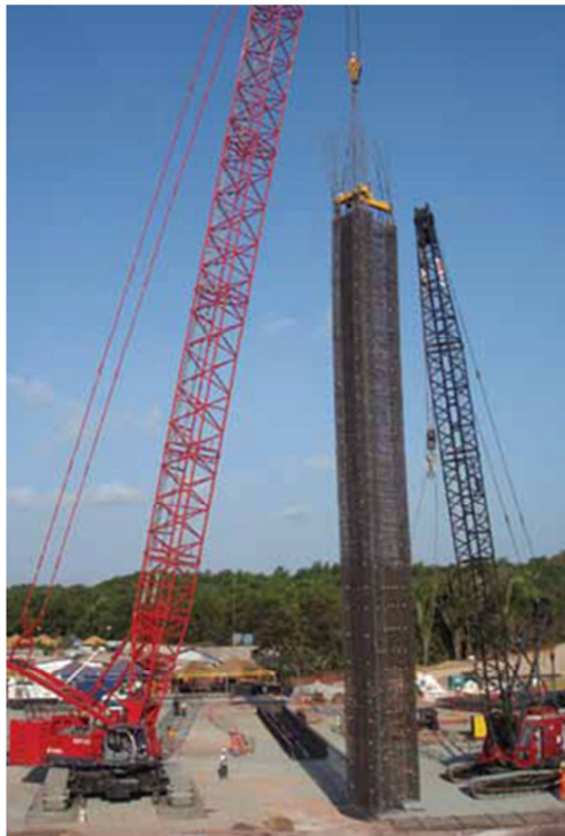
Figura 8 - Içamento da gaiola de armadura para parede diafragma (FONTE: Costa Fortuna, 2014).
