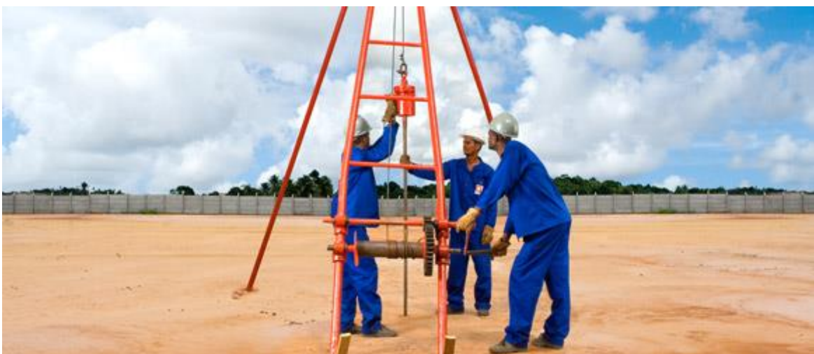
Figura 7 – Sondagem à percussão
