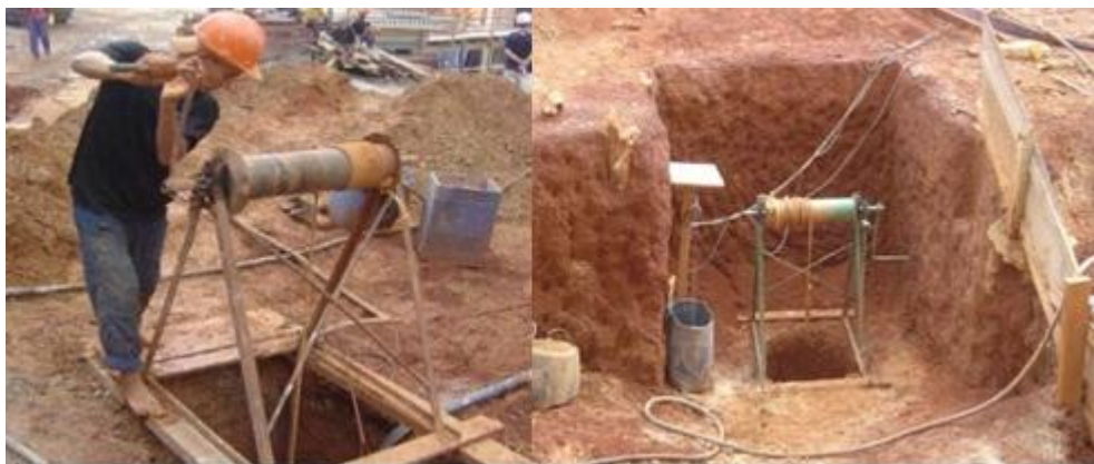
Figura 4 - Execução de tubulão a céu aberto.
