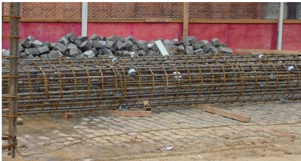
Figura 9 - Armadura para Estacas Hélice.
