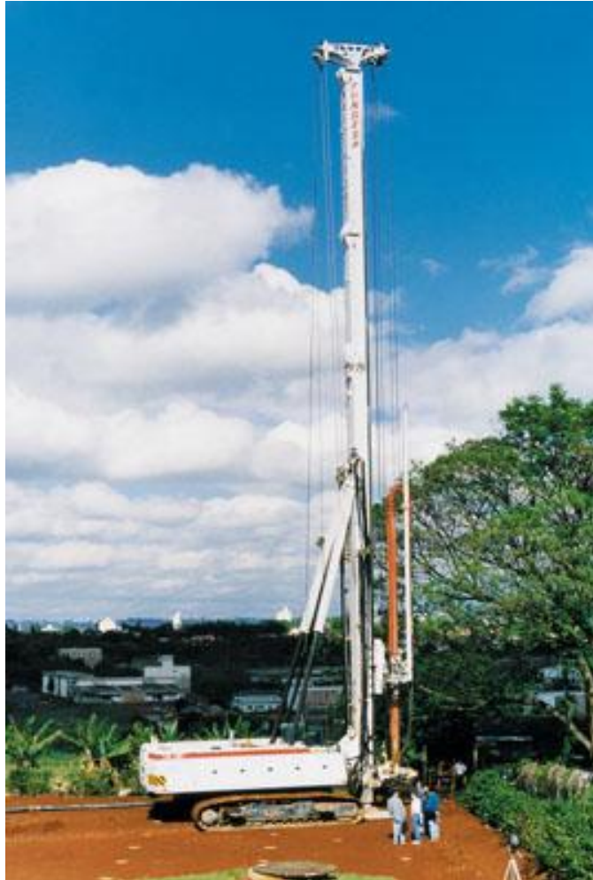
Figura 7 – Execução de estaca Hélice Ômega (FUNDESP, 2002).
