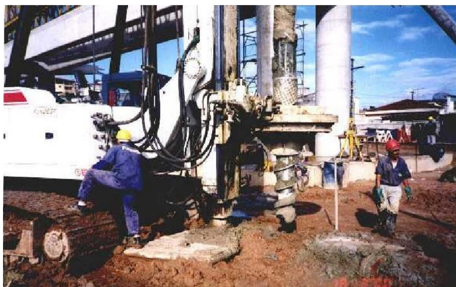
Figura 8 – Preparo para iniciar a perfuração.
