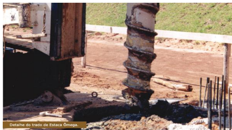
Figura 1.2 – Exemplo real de estaca hélice contínua ômega, FONTE (FUNDESP 2009).
