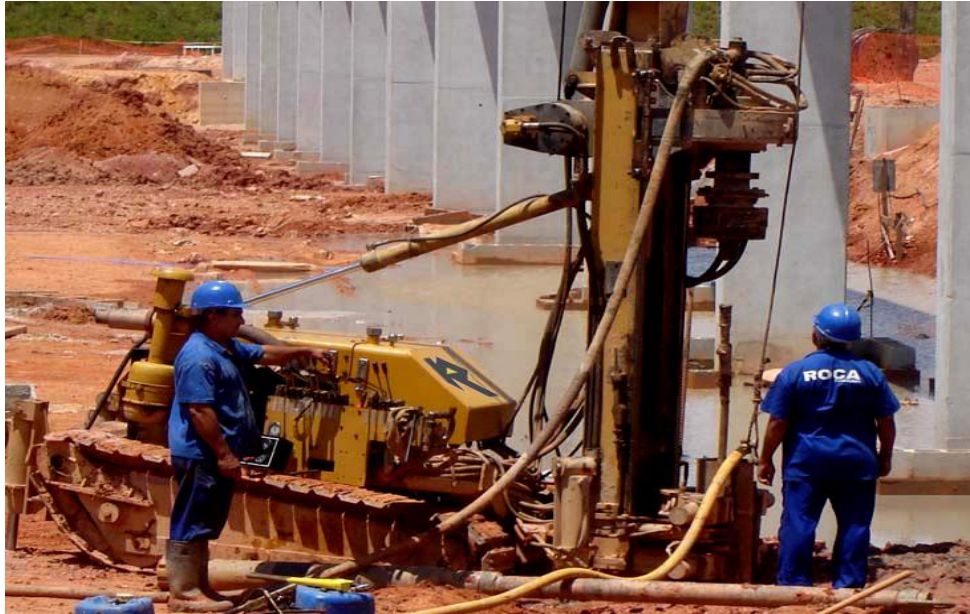
Figura 1.3 – Exemplo real de estaca raiz, FONTE (FUNDESP 2009).
