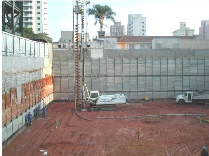
Figura 1.1 – Exemplo real de estaca hélice contínua, FONTE (engenharia de solos e fundações LTDA 2009).
