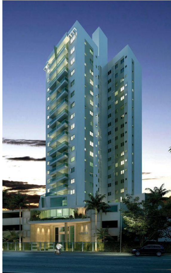
Figura 1.3. Fachada do edifício (Conscam, 2011).
