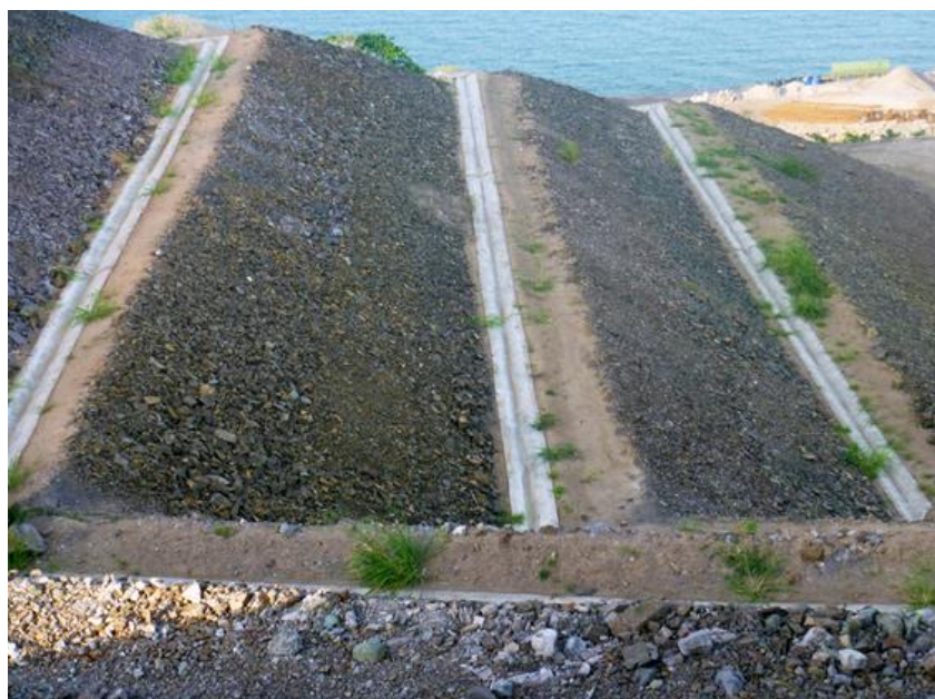
Figura 29: Valetas de proteção de aterro.
