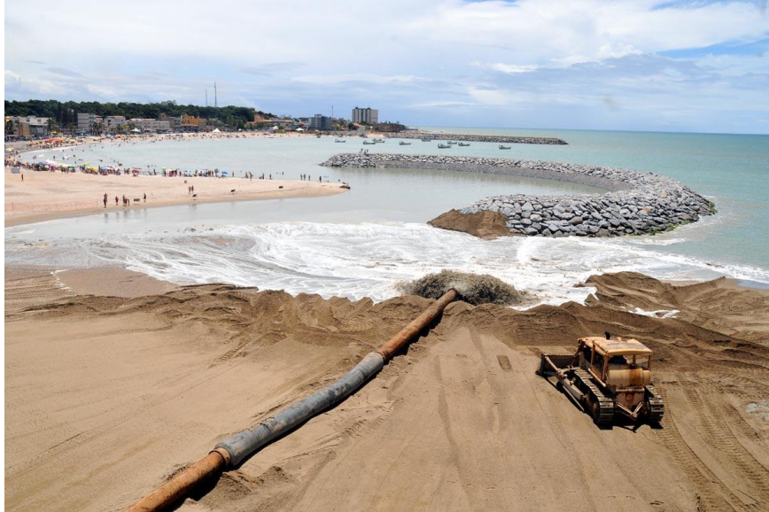
Figura 20: Dragagem executando lançamento de aterro hidráulico em praia para ampliação da faixa de areia.
