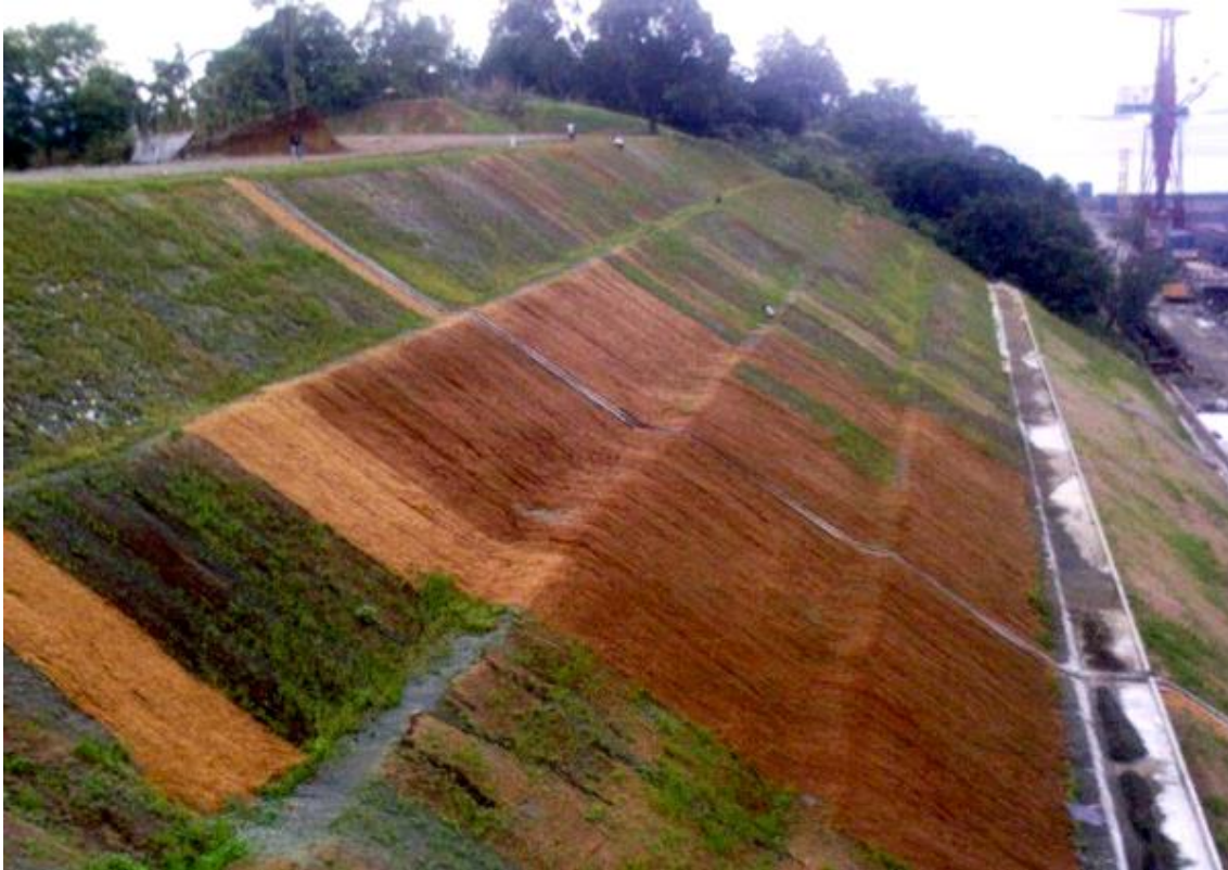
Figura 27: Exemplo de aplicação de BioMac como revestimento de talude.
