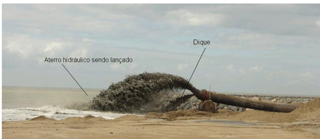
Figura 21: Lançamento de aterro hidráulico.
