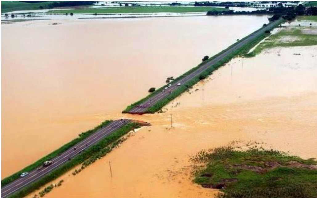
Figura 10 - Ruptura da BR-356.
