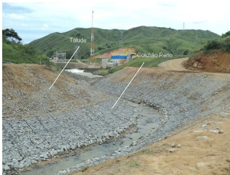
Figura 25: Colchão Reno como revestimento no pé de talude.
