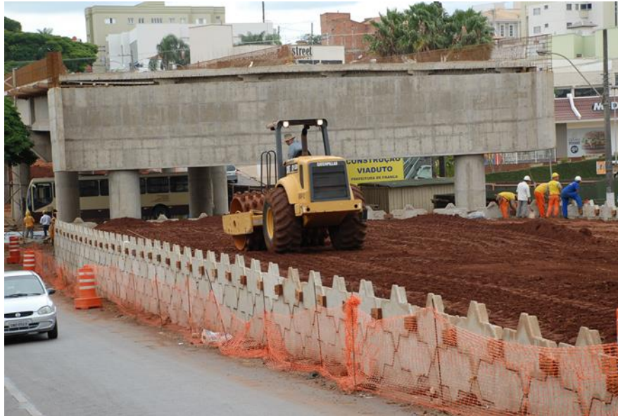
Figura 3.28 - Compactação do solo
