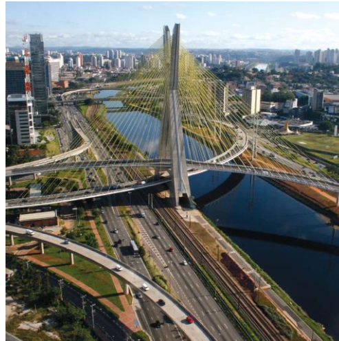
Figura 1.6 - Ponte estaiada sobre o Rio Pinheiros em São Paulo
