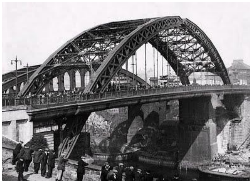
Figura 1.4 - Ponte em ferro fundido Wearmouth Inglaterra 1796
