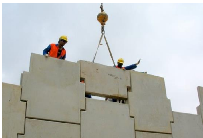
Figura 3.30 - Içamento das escamas
