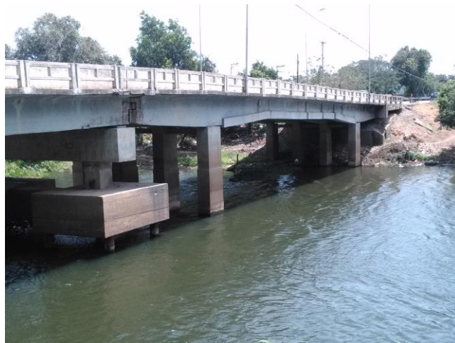
Figura 2.7 - Atual ponte sobre o Rio Ururaí
