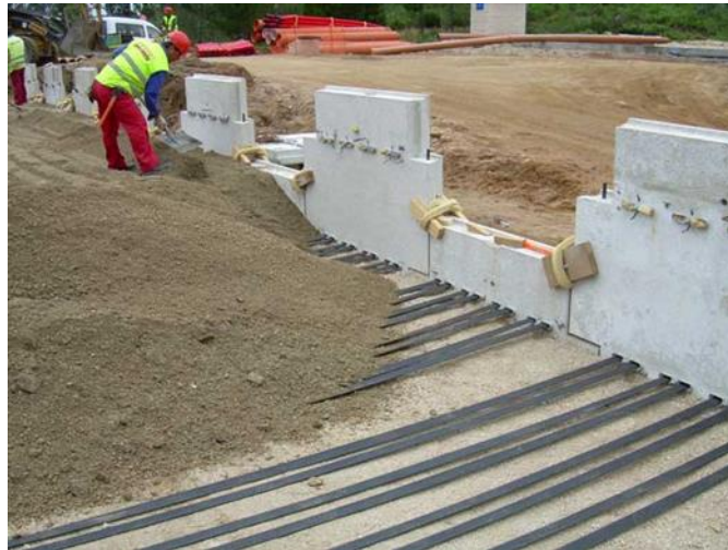
Figura 3.31 - Instalação das armaduras de tração
