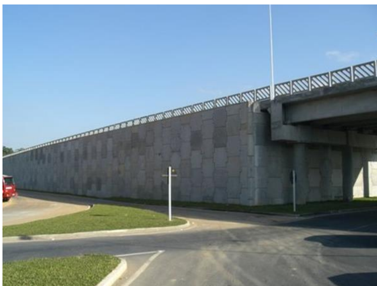
Figura 3.27 - Contenção em Terra Armada
