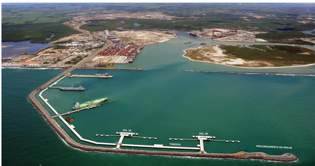
Figura 1 - Molhe do Porto de Suape, PE. Fonte: Site do Porto de Suape.
