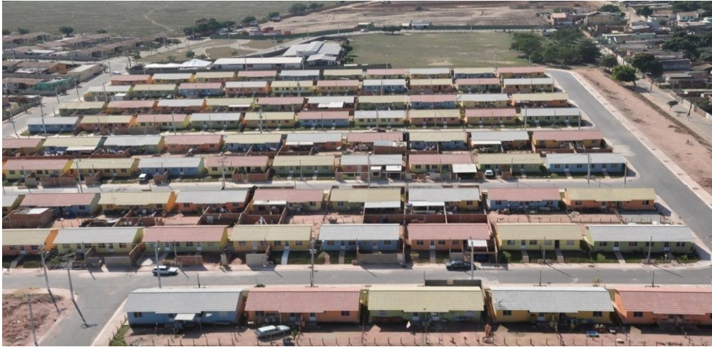
Foto panorâmica de um dos conjuntos habitacionais Fonte: Site oficial da prefeitura de Campos. 2015
