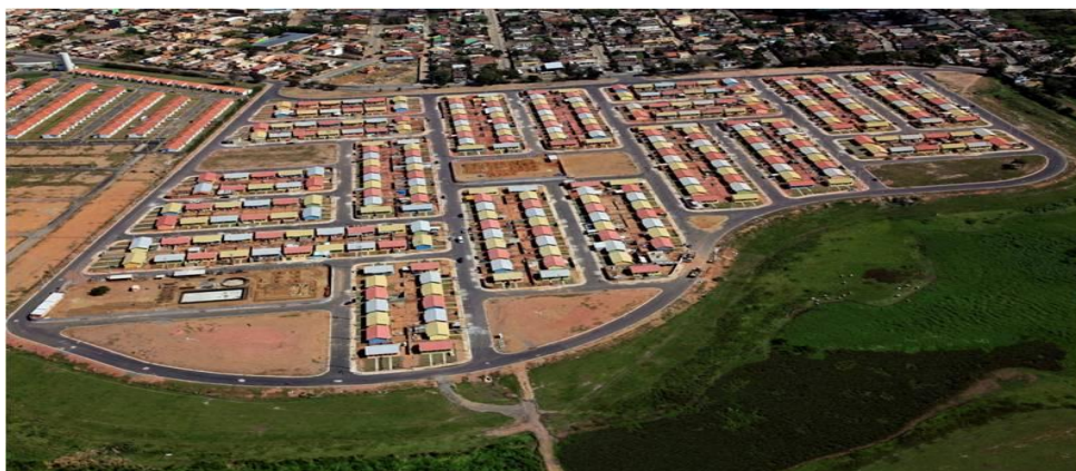
Foto Panorâmica. Conjunto Santa Rosa. Fonte: PCE. 2015
