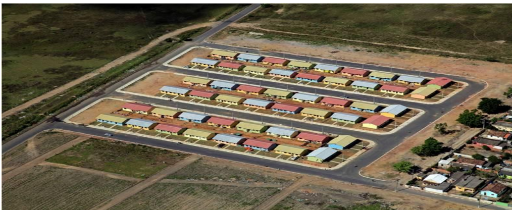
Foto Panorâmica. Conjunto Travessão. Fonte: PCE. 2015
