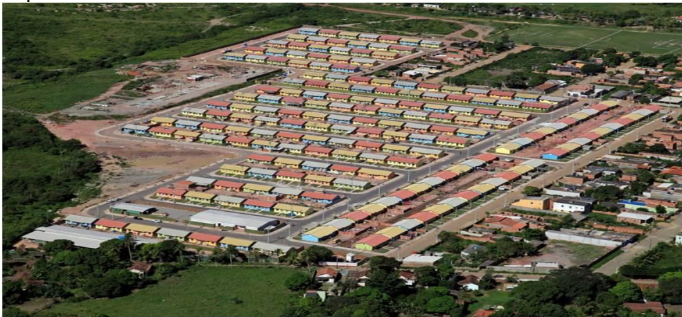
Foto Panorâmica. Conjunto Tapera I. Fonte: PCE. 2015
