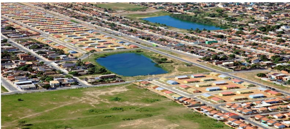
Foto Panorâmica. Conjunto Novo Eldorado III. Fonte: PCE. 2015
