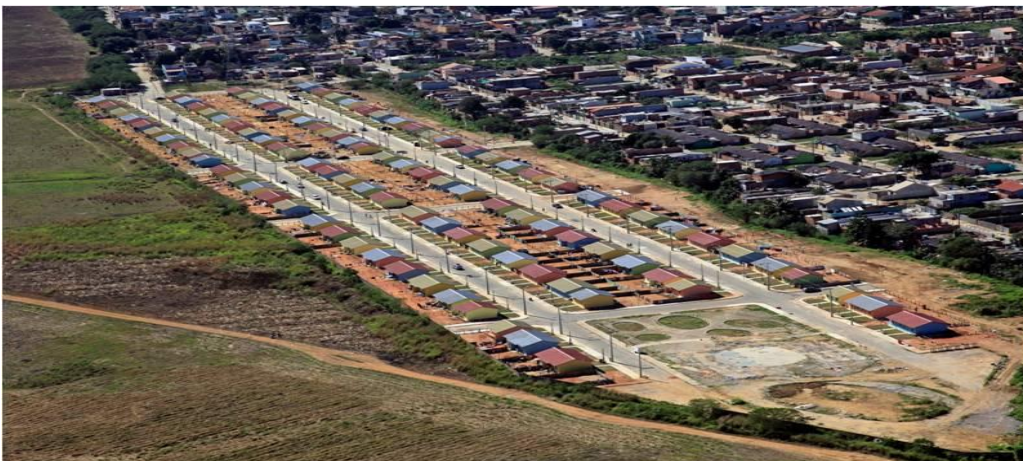
Foto Panorâmica. Conjunto Penha. Fonte: PCE. 2015
