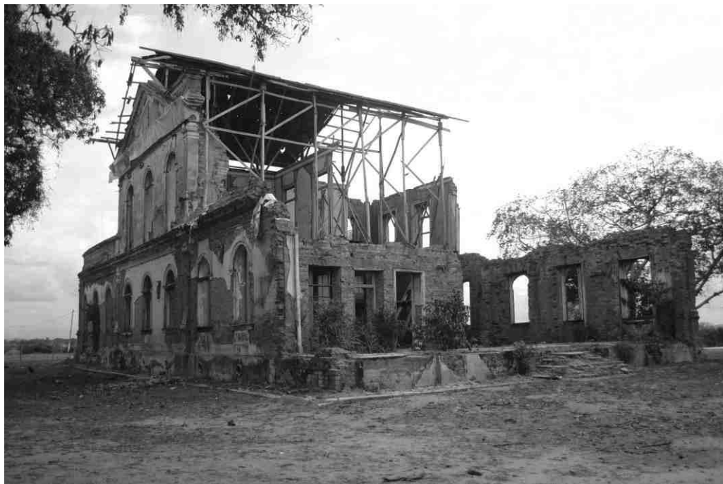
Figura 9 – Atual estado da casa-grande da Fazenda Machadinho. Fonte: Fotografia Luciana Azevedo.
