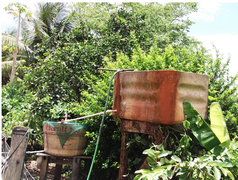
Imagem 6 – Sistema de filtro com caixas de areia com objetivo de eliminar parte da “ferrugem” e impurezas da água consumida no assentamento (núcleo I, lote 381).
