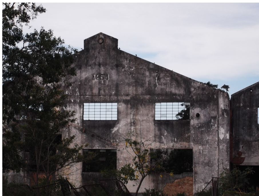
Imagem 1 – Antigas instalações da usina São João.
