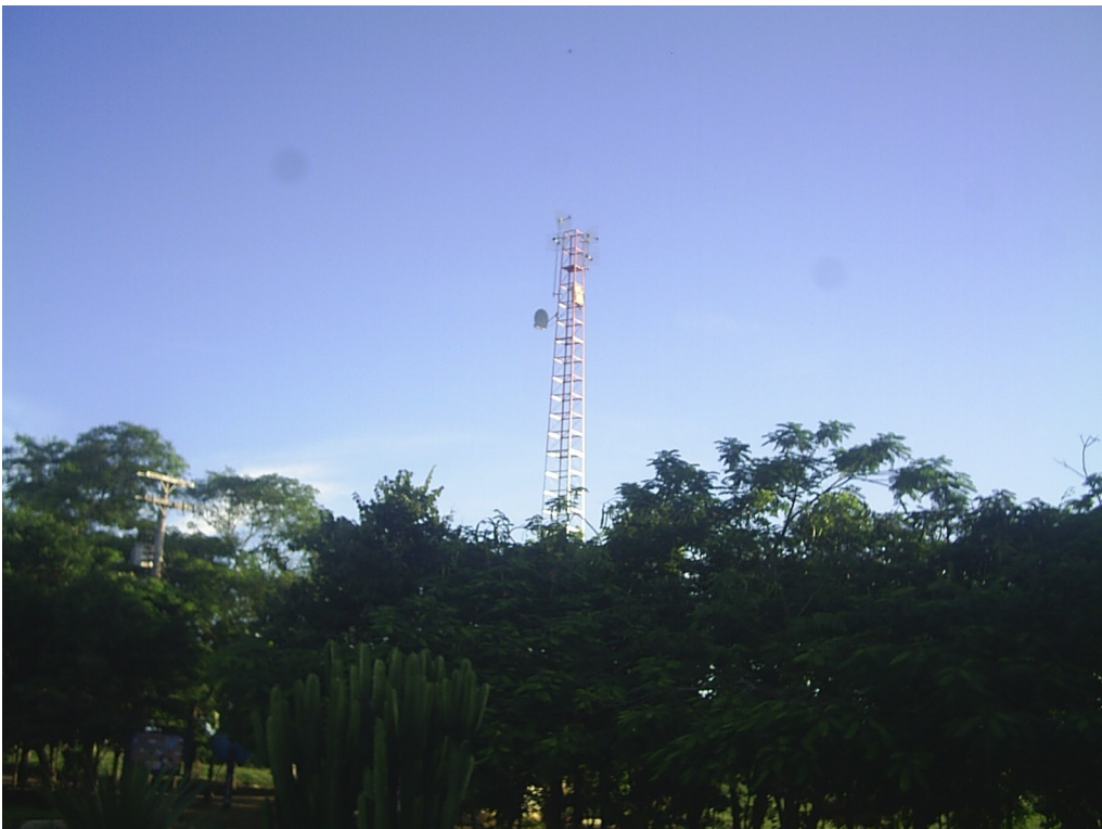
Foto 4 – Antena repetidora do sinal da Internet Cidadão. Fonte: Rafael Lobo (2008).
