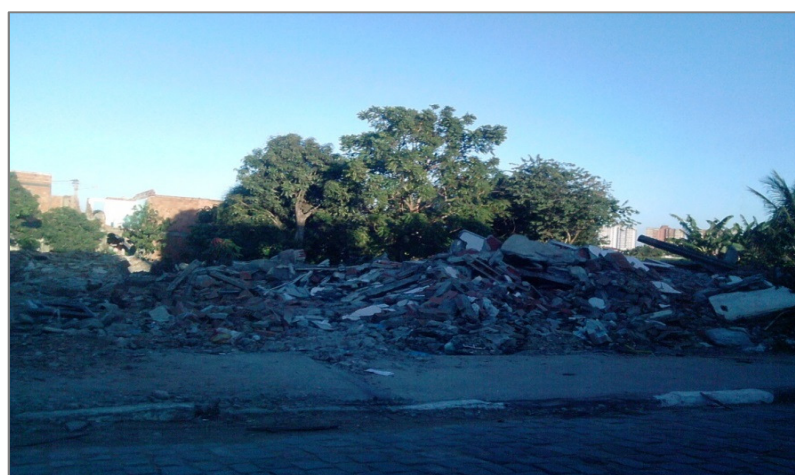
Figura: Moradias derrubadas às margens da lagoa do Sapo, subdistrito de Guarus. Fonte: Acervo próprio, 2012.
