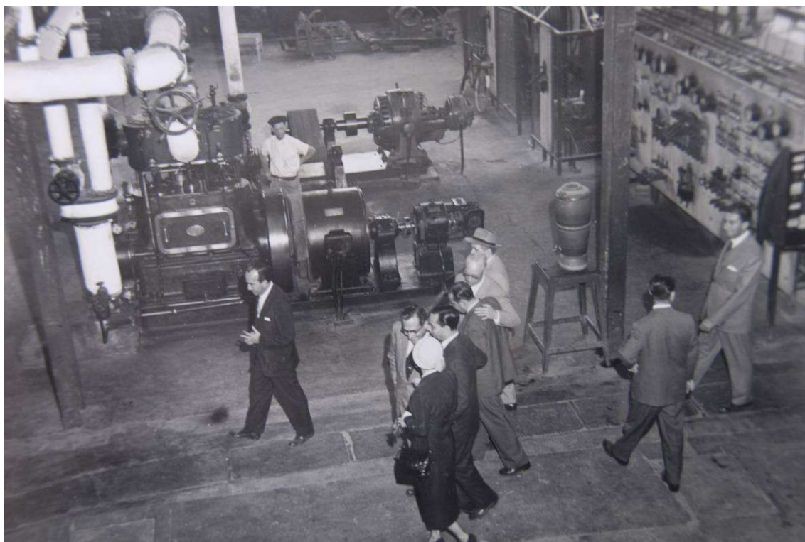
(Progresso de Campos identificado pela Usina do Queimado – o maquinário veio diretamente da Inglaterra. Acervo Eduardo Nogueira)
