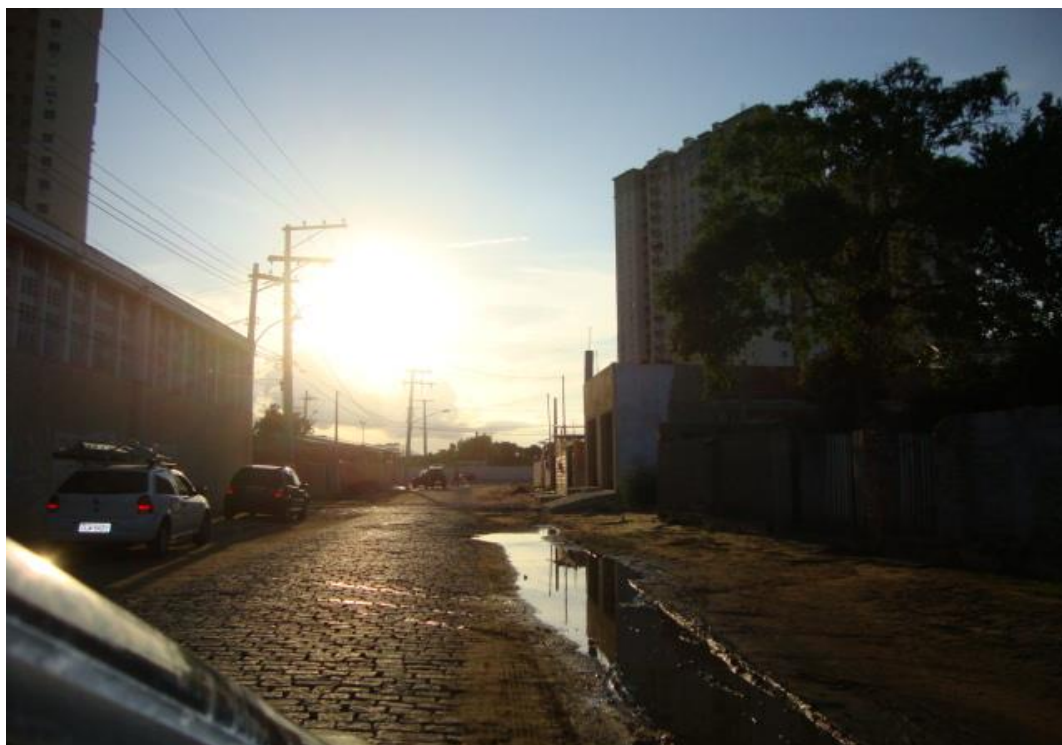
Figura 9 Rua de acesso ao Residencial Fit Vivai. Campos dos Goytacazes.
