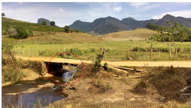
Figura 5. Ponto em que a laje de pedra foi explodida 23
