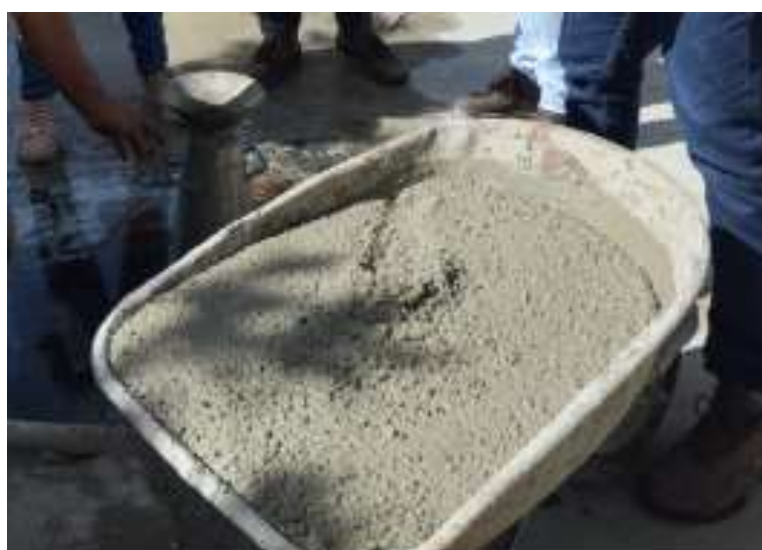
Figura 64 - Concreto utilizado na concretagem das vigas.
