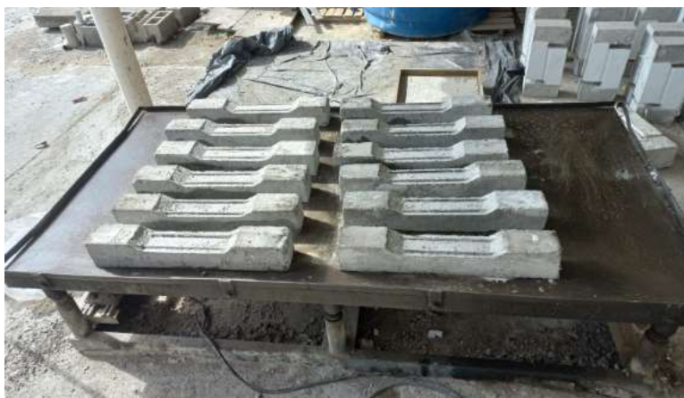
Figura 49 - Vigas sem o entalhe de isopor.
