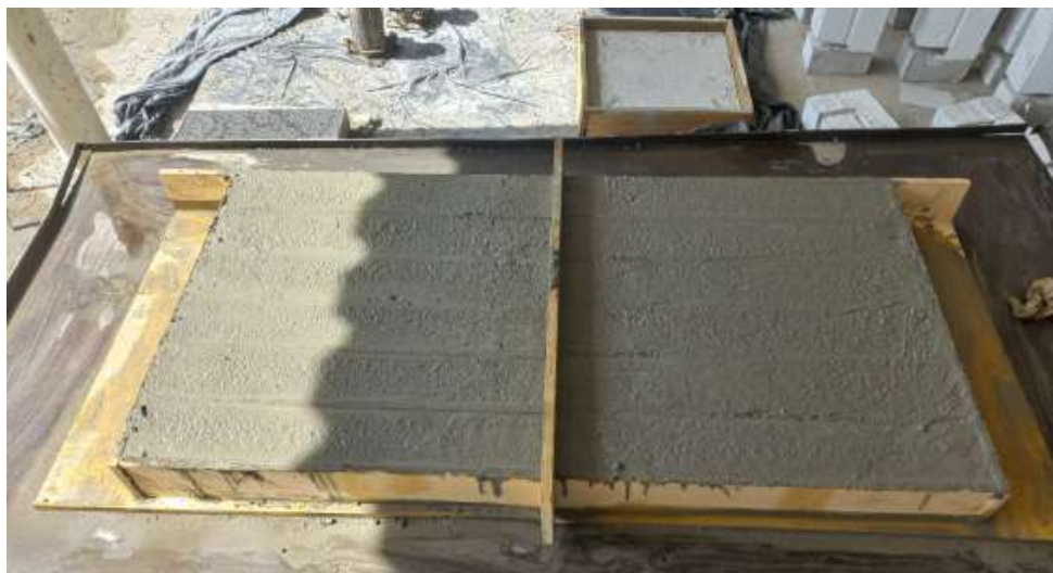
Figura 46 - Fôrma de concreto preenchida com concreto.
