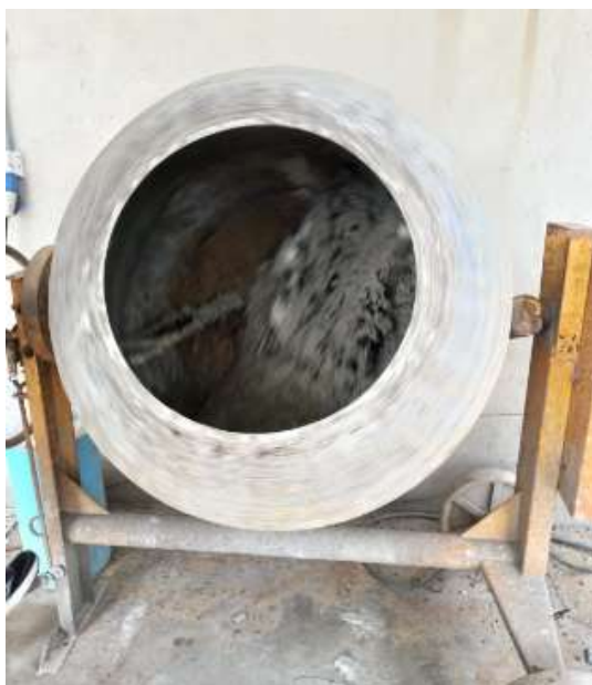
Figura 48 - Confeção do concreto.
