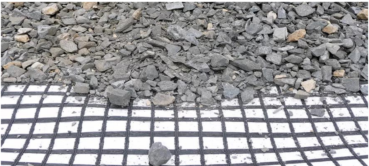
c) Reforço de lastro
