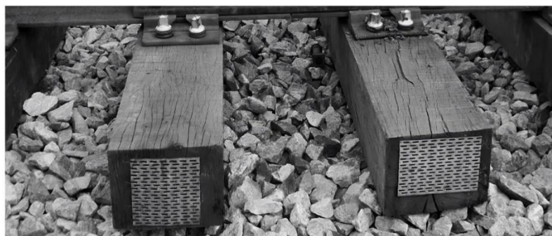
Figura 2.4 - Dormentes com proteção anti-rachante (Rosa e Ribeiro, 2016).
