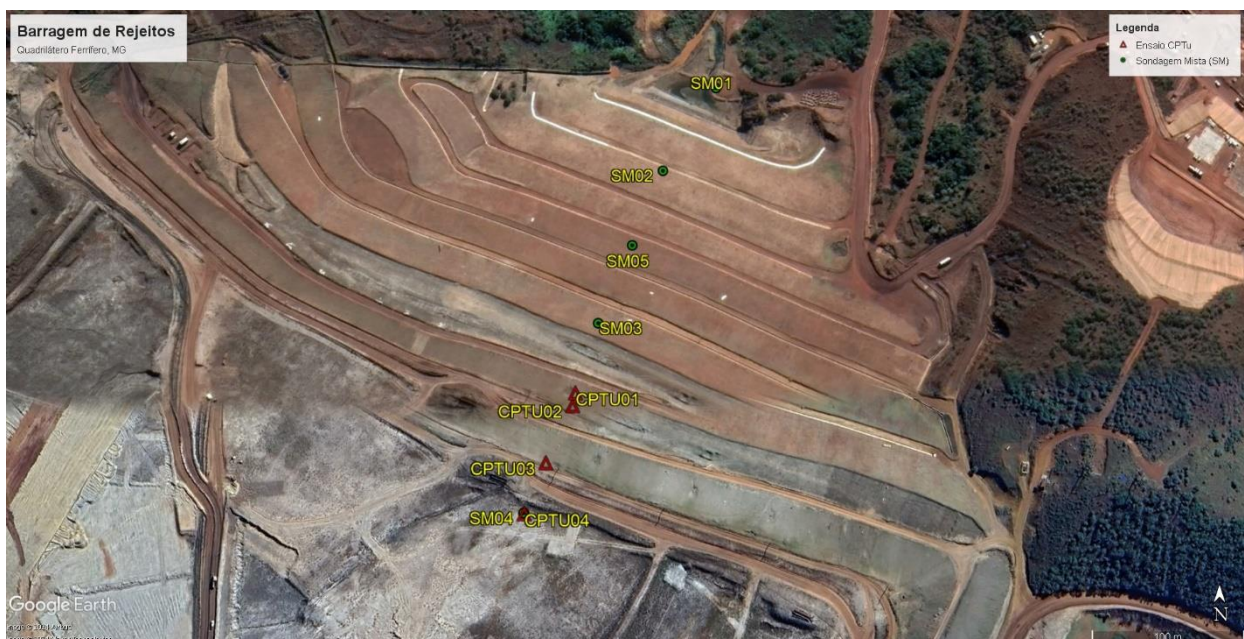
Figura 21 – Barragem de Rejeitos de Mineração, onde, os círculos verdes indicam os pontos de sondagens mistas com a realização de ensaios SPT e amostragem, e os triângulos vermelhos indicam os pontos de ensaios CPTu. Os ensaios laboratoriais foram executados em amostras obtidas das sondagens mistas.
