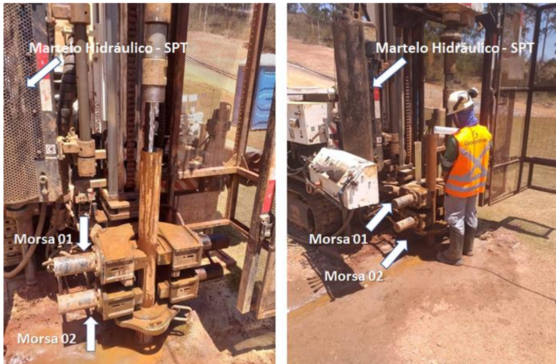
Figura 12 – Equipamento de sondagem geotécnica Boart Longyear DB 525-LX (Geocontrol, 2019).
