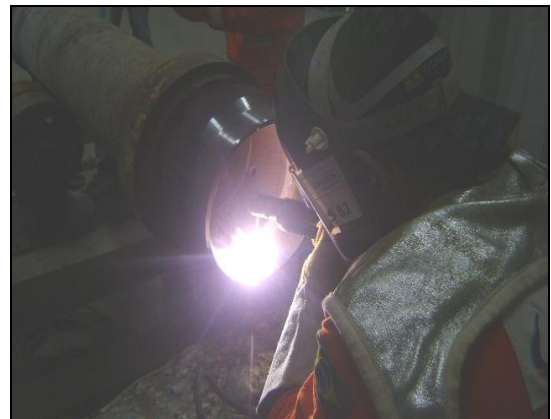
d) Execução da soldagem.
