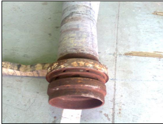
a) Tubo Riser como recebido
