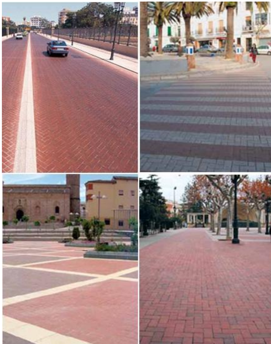
Figura 3.10. Pavimentação na Espanha com adoquim cerâmico: exuberância de cores e formas de implantação. Fonte: MALPESA (2006).
