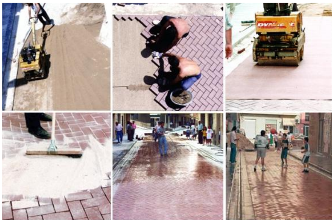
Figura 3.13. Implantação dos adoquins cerâmicos como pavimentos flexíveis. Fonte: MALPESA (2008).
