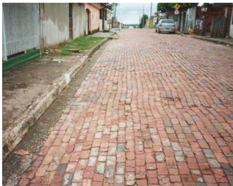
Figura 3.8. Pavimentação com tijolo maciço de argila em Rio Branco – AC. Fonte: NASCIMENTO (2005).
