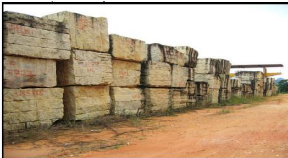
Figura 6: Estoque de blocos já extraídos. Fonte: (Vidal et. al., 2001)
