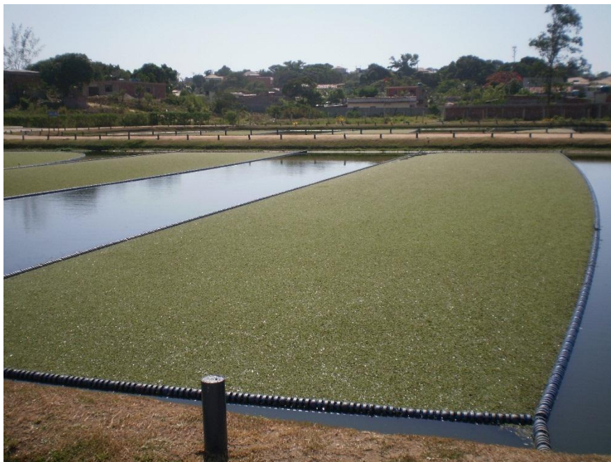
Figura 5. Lagoa de tratamento com plantas aquáticas onde ocorre a etapa do tratamento secundário. Na imagem a macrófita flutuante S. airiculata . Foto: acervo da autora (com a devida autorização).
