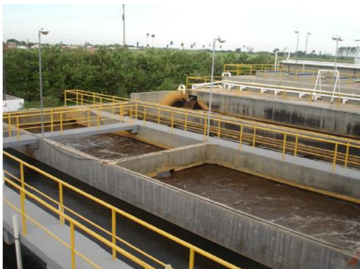
Figura 4. Complexo de tratamento de esgoto da CAP - ETE Chatuba Campos - R. J.
