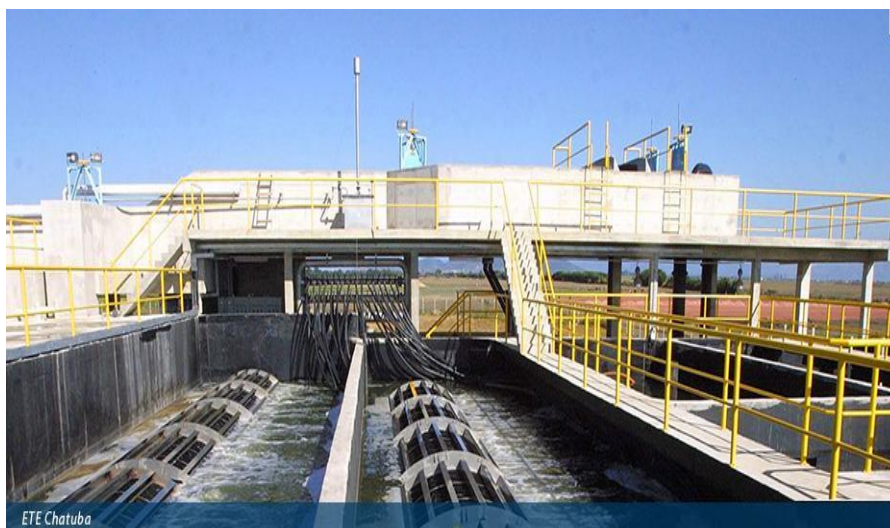
Figura 15. Vista parcial da Estação de Tratamento de Esgoto de Chatuba, Campos dos Goytacazes-RJ.
