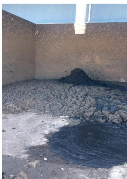
Figura 5. Lodo gerado na ETE da CAP.
