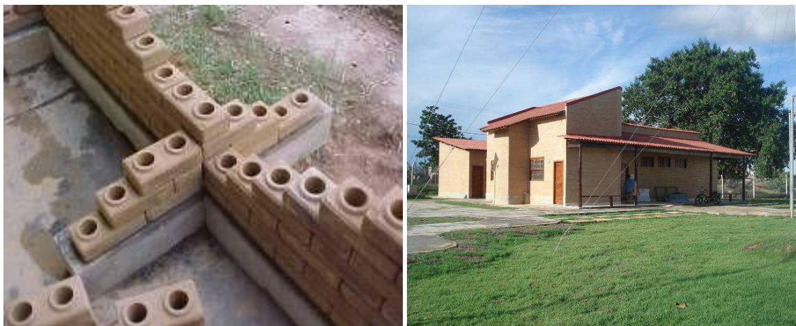
Figura 2.7. – (a) Tijolos de solo-cimento e (b) Construção civil em solo-cimento (Lima, 2006; Destefani, 2009).
