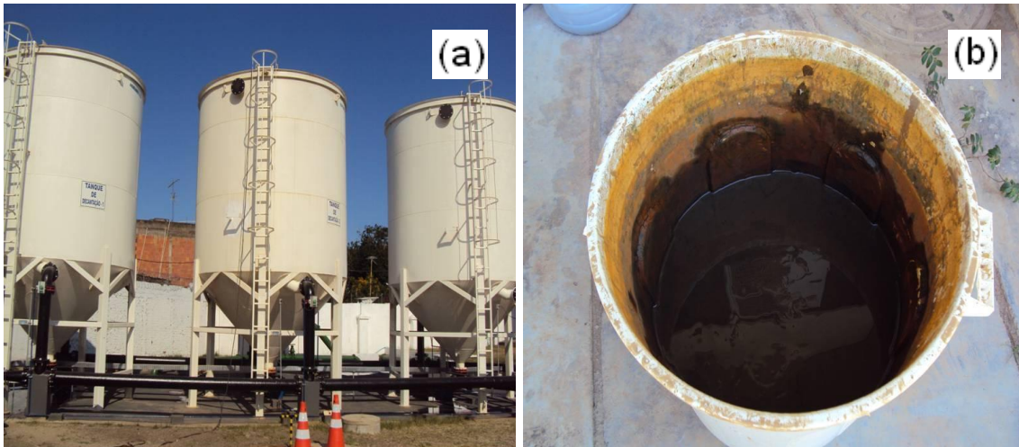
Figura 3.3. – (a) Tanques de decantação da ETA de Campos dos Goytacazes e (b) Lodo de ETA em processo de decantação.
