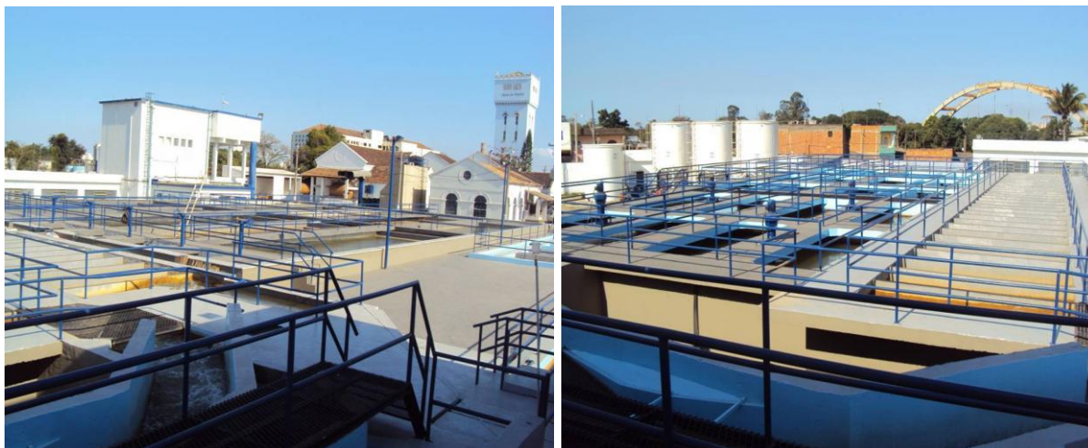
Figura 3.2. – Vista parcial da Estação de Tratamento de Água de Campos dos Goytacazes.
