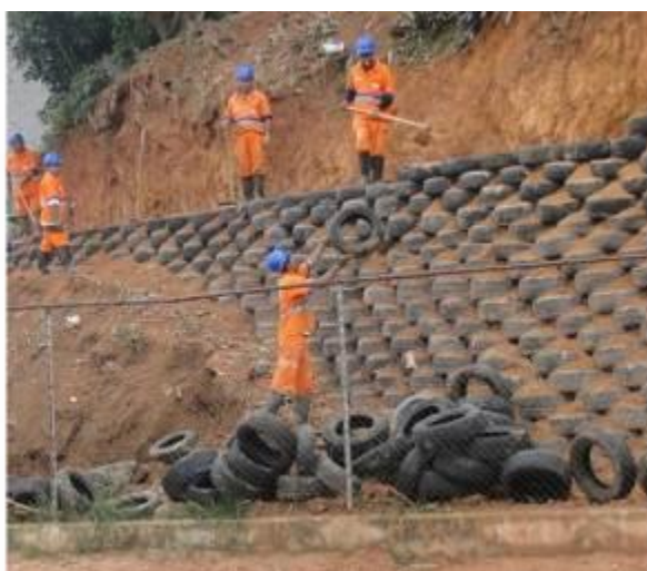
Figura 10: Muro de contenção.
