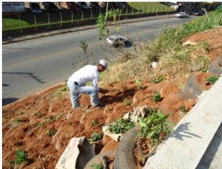
Figura 16: Reutilização de pneu em obra de contenção de encosta
