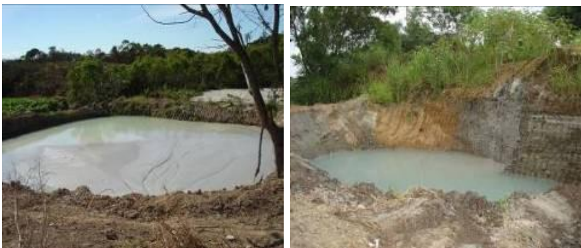
Figura 4.12. Lagoas de sedimentação de resíduo no solo em empresas de pequeno porte.
