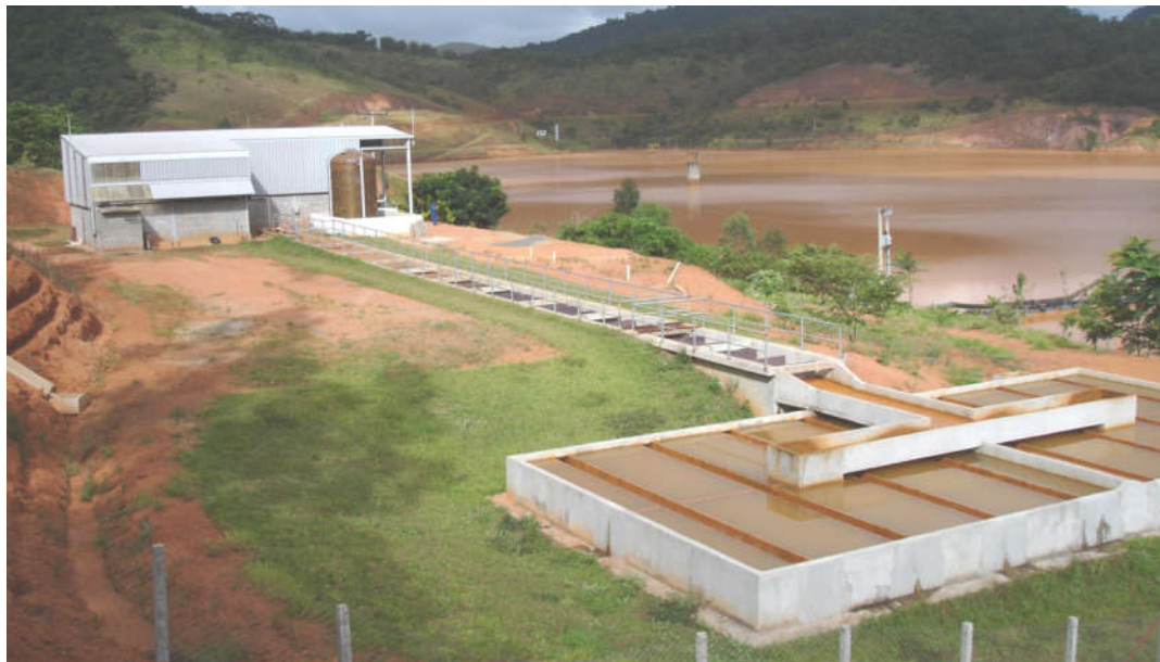
Figura 7: Estação de tratamento de efluentes de rejeitos de bauxita – Votorantim Metais/Alumínio (Votorantim Metais/Alumínio, 2015).
