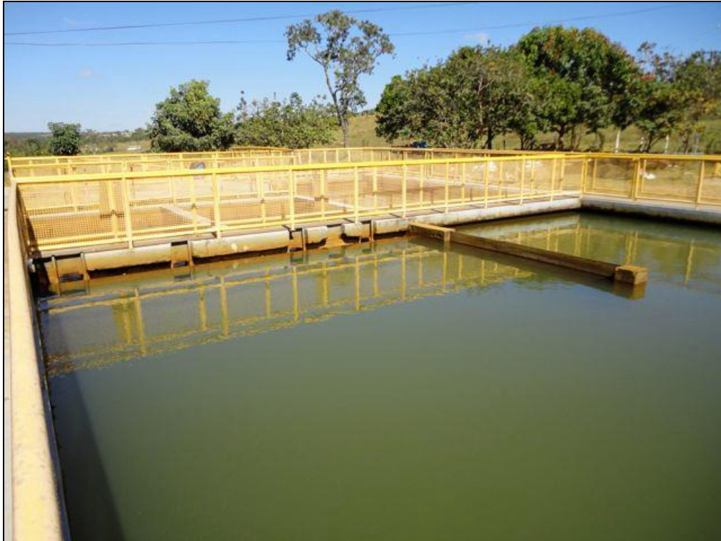
Figura 3.4 – Decantadores. Fonte: ANGELIM (2008).
