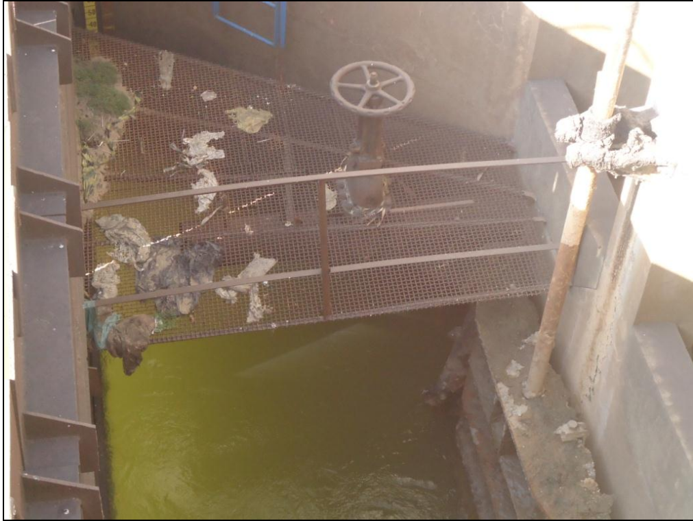
Figura 4.3 – Canal de captação.
