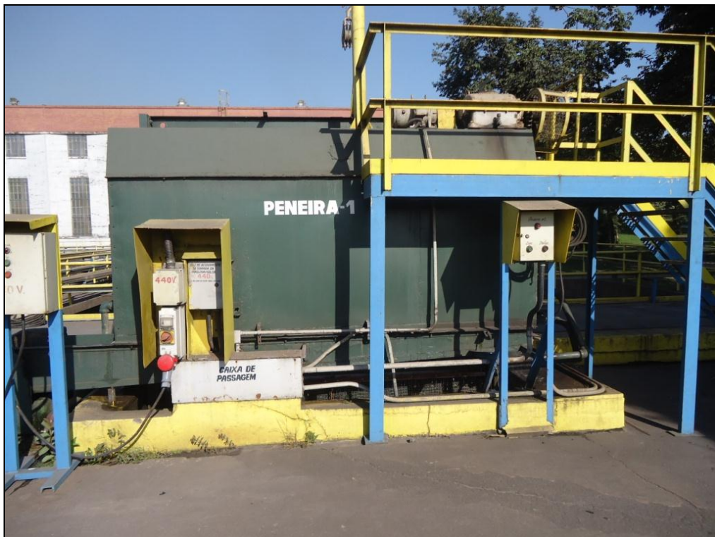
Figura 4.4 – Sistema primário de peneiramento de particulados em suspensão na água bruta.
