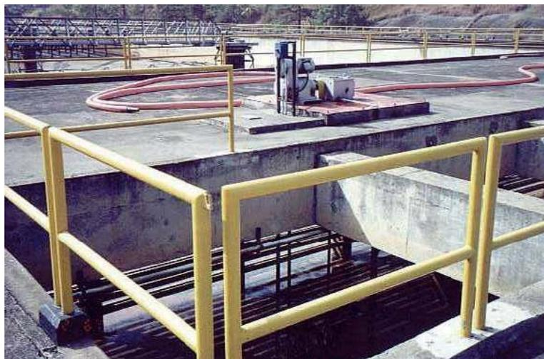
Figura 2.3 – Floculador mecanizado da ETA.
