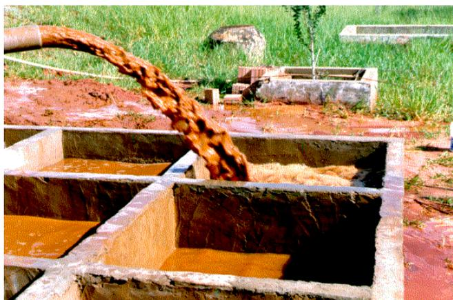
Figura 2.6 – Tanque de estocagem de lodo da ETA. Fonte: SABBAG e MORITA (2003).
