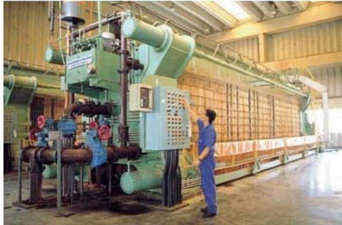
Figura 2.7- Filtro prensa desaguadora de lodo da ETA. Fonte: SABBAG e MORITA (2003).
