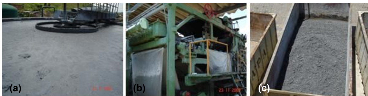
Figura 13 – Etapas de geração do lodo (a) decantador primário, (b) desaguador do lodo, (c) lodo gerado.
