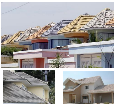
Figura 6: Fotos de residências com telhados executados com telhas de concreto
