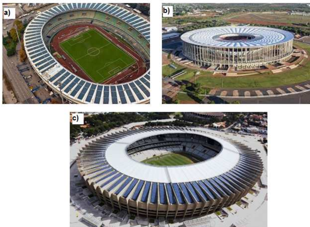
Figura 1.2- Estádios construídos com tecnologia fotovoltaica para Copa do Mundo sediada no Brasil em 2014: a) Estádio do Maracanã ( Rio de Janeiro), b) Arena Mané Garrincha (Brasília) e c) Estádio do Mineirão (Belo Horizonte) (Disponível em: http://www.jornaldaenergia.com.br/ , 10/10/2014).
