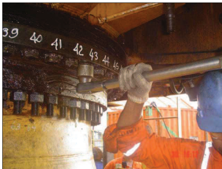
Figura (2.14) – Aplicação manual de torqueamento.
