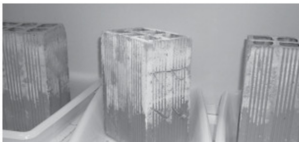
Figura 4.15 – Blocos apresentando eflorescência (ALVES et al. , 2003).
