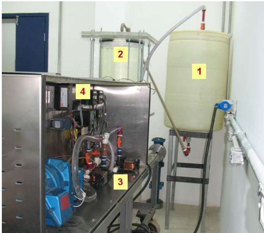
Figura 3.4 - Célula de corrosão, visão da parte traseira: 1- Reservatório principal do fluido 200 L, 2- Reservatório intermediário do fluido 60 L, 3- Bombas centrífugas e 4- Componentes eletrônicos dos indicadores e controladores.
