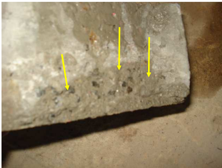
Figura 5.15 – T14 extremamente rugoso e T19 com fluidez excessiva.
