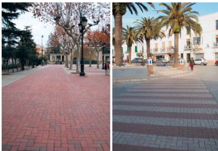
Figura 4.2: Exemplos de aplicações de pavimentos cerâmicos extrudados – adoquim (MALPESA, 2010).
